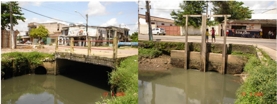
Fig 17 e 18: Situação atual da Avenida Bernardo Sayão (Estrada Nova). Detalhes de bueiro unicelular e sistemas de comportas emergenciais. Fonte: BELÉM, 2006 a.
