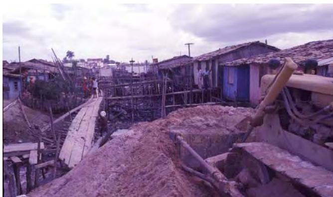
Figura 80 – Salvador, Bahia, Alagados – aterro mecânico realizado com material retirado de jazidas marítima.
