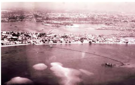
Figura 28 – Salvador, Bahia, Alagados, 1975 - vista aérea mostrando: Jazida de areia em frente à praia do Bugari; draga e tubulação flutuante de recalque; área de Alagados ao fundo e o aterro de Joanes em fase de execução.
